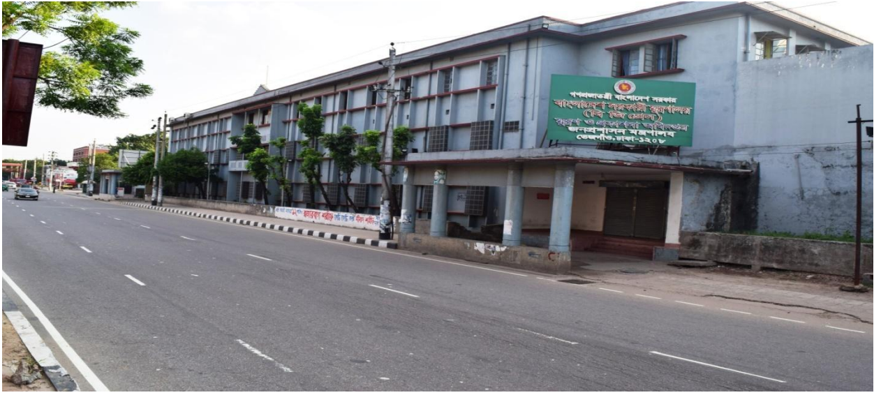
বাংলাদেশ সরকারি মুদ্রণালয়ের মূল ভবন
